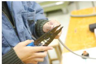
電気工事実習
